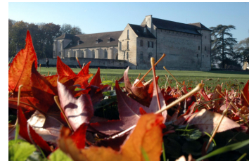
Salles abbatiales et bâtiment des latrines
